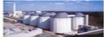
陸揚後の石炭はベルトコンベヤで石炭サイロへ送られ、一時的に貯蔵
