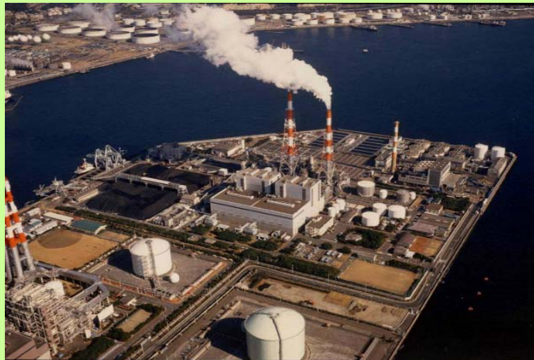
磯子火力発電所(横浜市) 1967年運転開始
