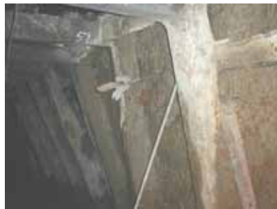
セメント注入パイプ
