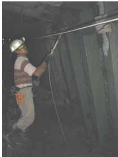
セメント吹き付け
