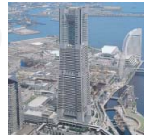
横浜ランドマークタワー(フライアッシュを含んだコンクリート使用)
