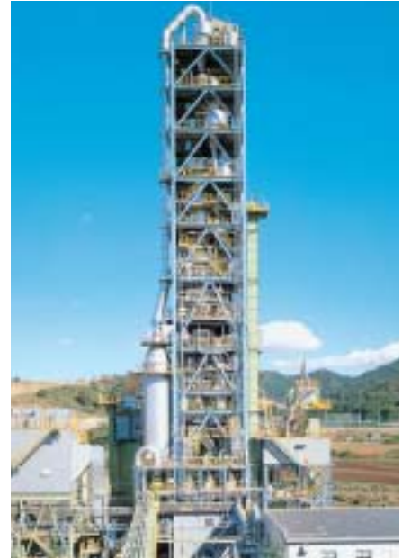
流動床セメント製造スケールアッププラント (焼成量200トン/日)
