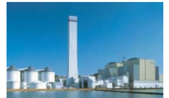
橘湾火力発電所
